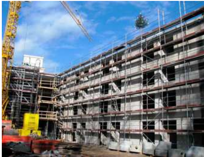
Der Neubau des Alten- und Altenpflegeheims St. Franziskus in Bad Säckingen | Foto: Michael Gottstein
